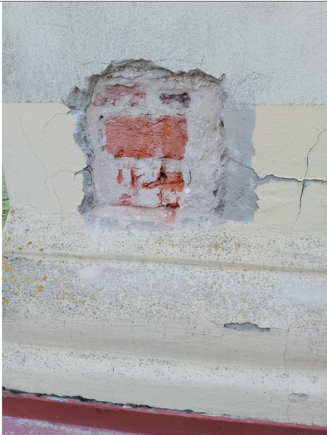
Fot 5. Badanie sondażowe schodkowe wykonano na środkowej ścianie dzwonnicy
