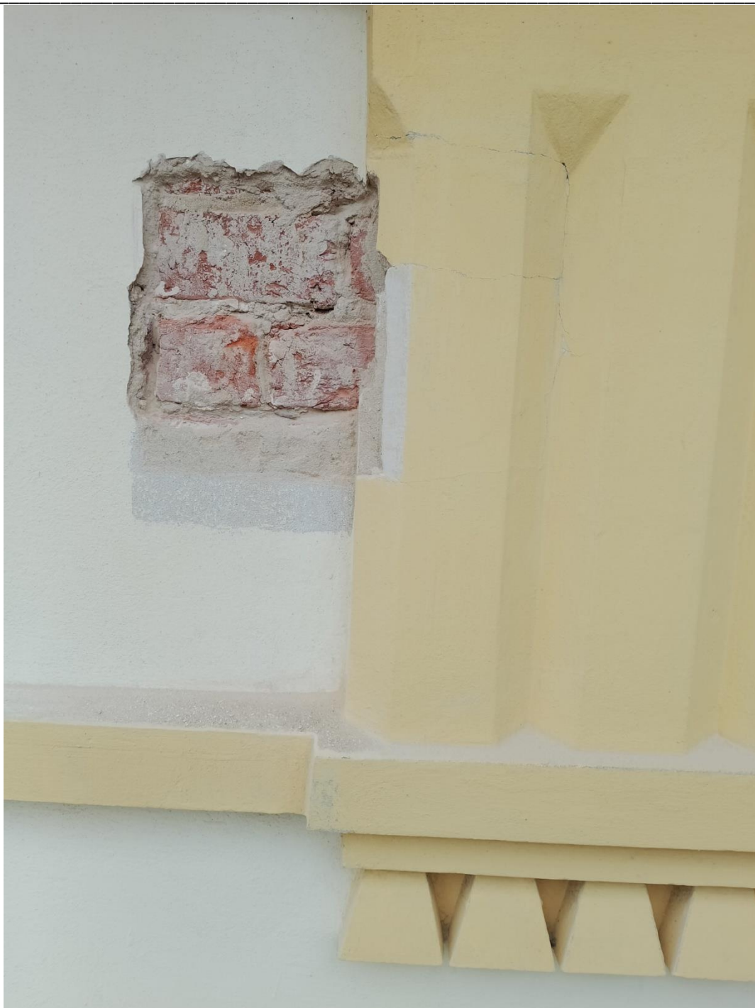
Fot 2. Badanie sondażowe schodkowe wykonane na południowej ścianie przy górnym gzymsie kościoła
