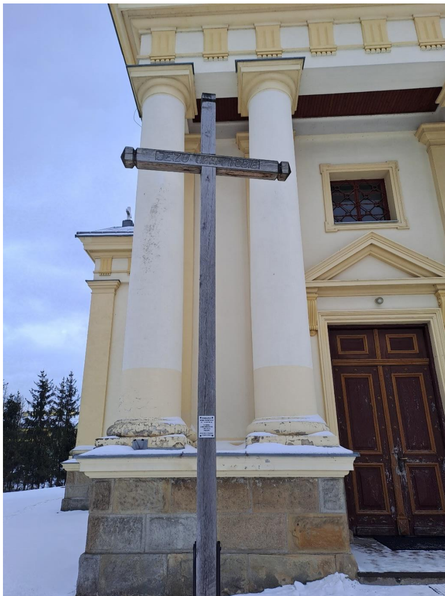
Fot 15. Elewacja frontowa kościoła
