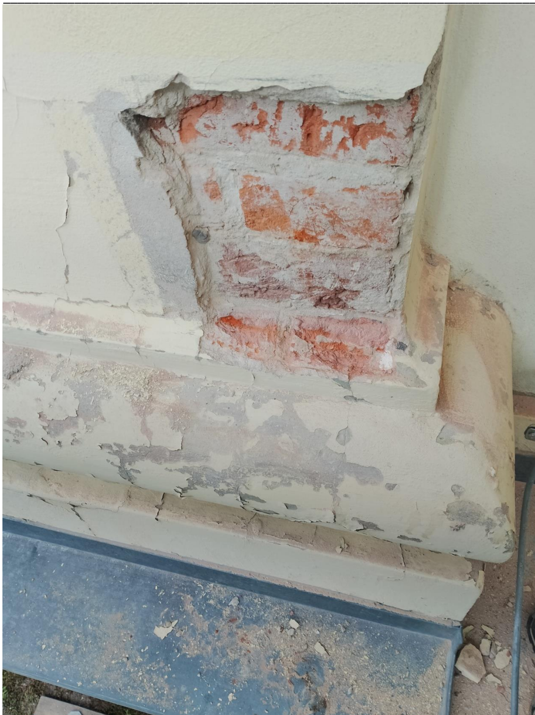
Fot 3. Badanie sondażowe pasowe wykonane na południowej ścianie przy dolnym gzymsie kościoła.
