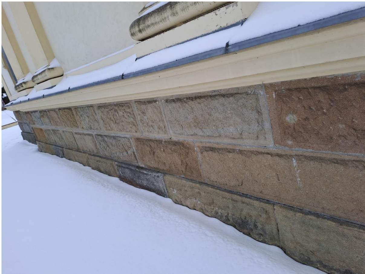
Fot 13. Cokół kamienny elewacji kościoła
