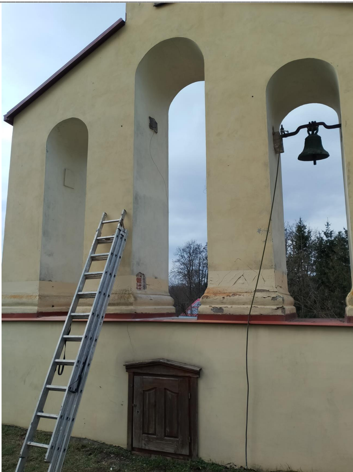
Fot 4. Badanie sondażowe wykonano na środkowej ścianie dzwonnicy.
