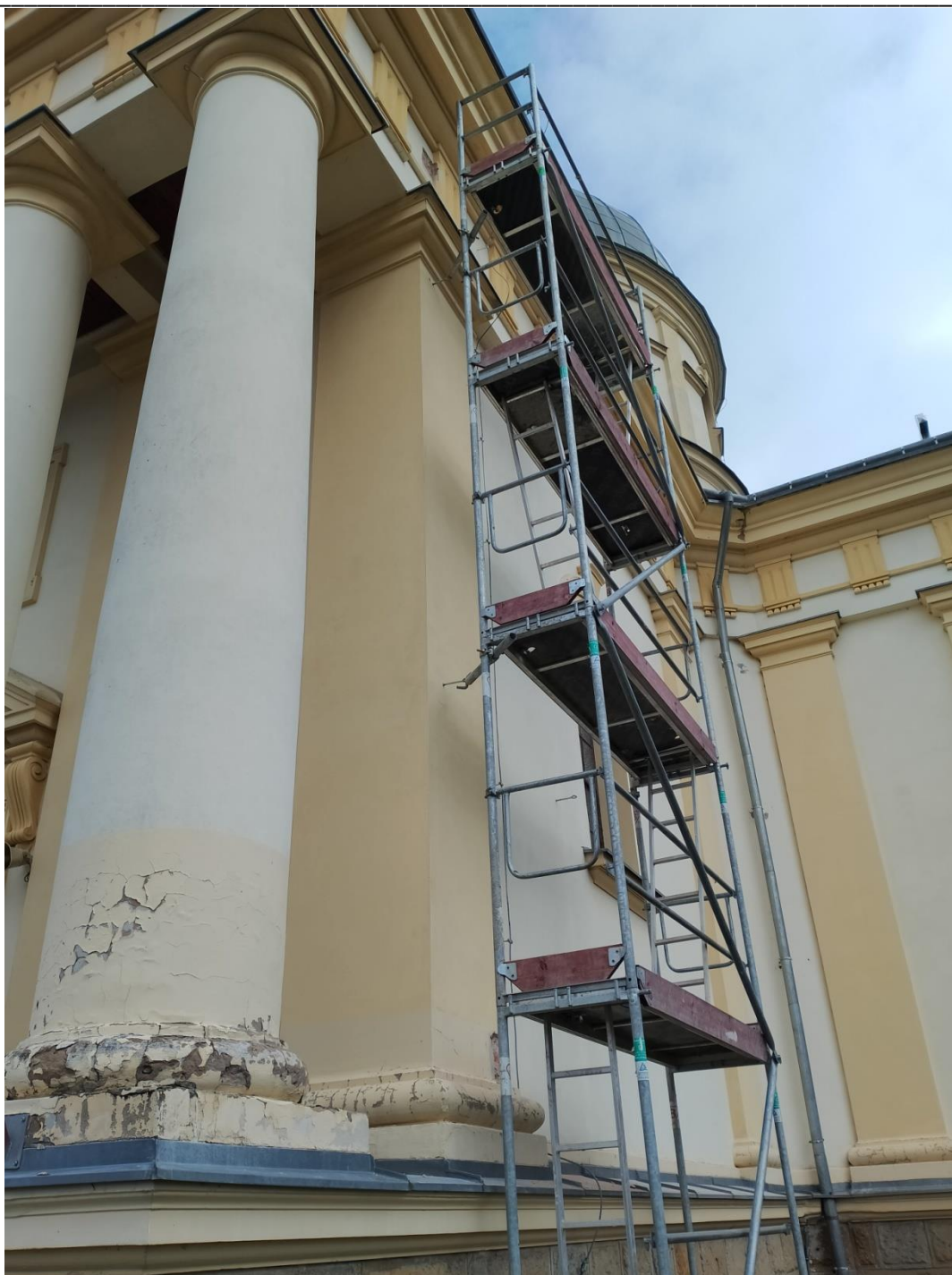
Fot 1. Badania sondażowe wykonane na południowej ścianie przy górnym i dolnym gzymsie kościoła
